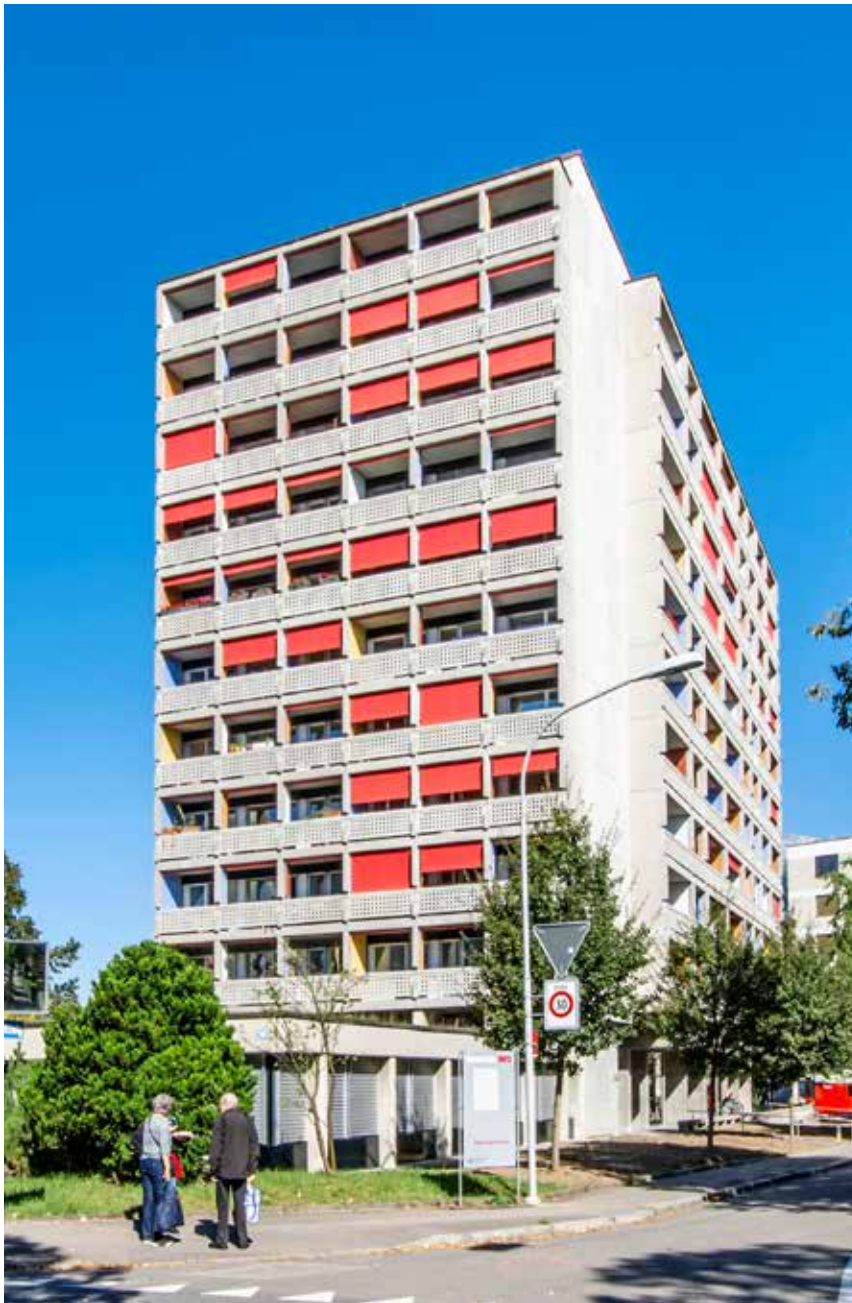
Strassenfassade mit vorgelagerter GBL-Geschäftsstelle. Die neuen Fassadenplatten aus Faserzement unterscheiden sich kaum von den früheren Betonelementen.
