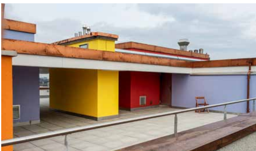
Die ebenfalls sanierte Dachterrasse steht allen Bewohnerinnen und Bewohnern zur Verfügung.
