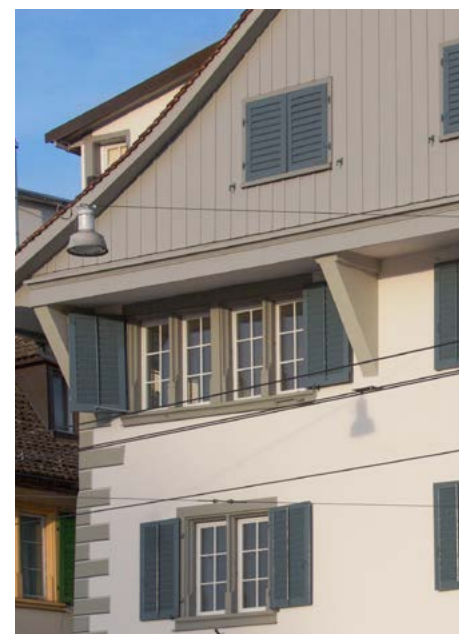
Haus zum Lämmli, Zürich, Keim'sche Silikattechnik, Soldalit-Anstrich, 1-jährig
