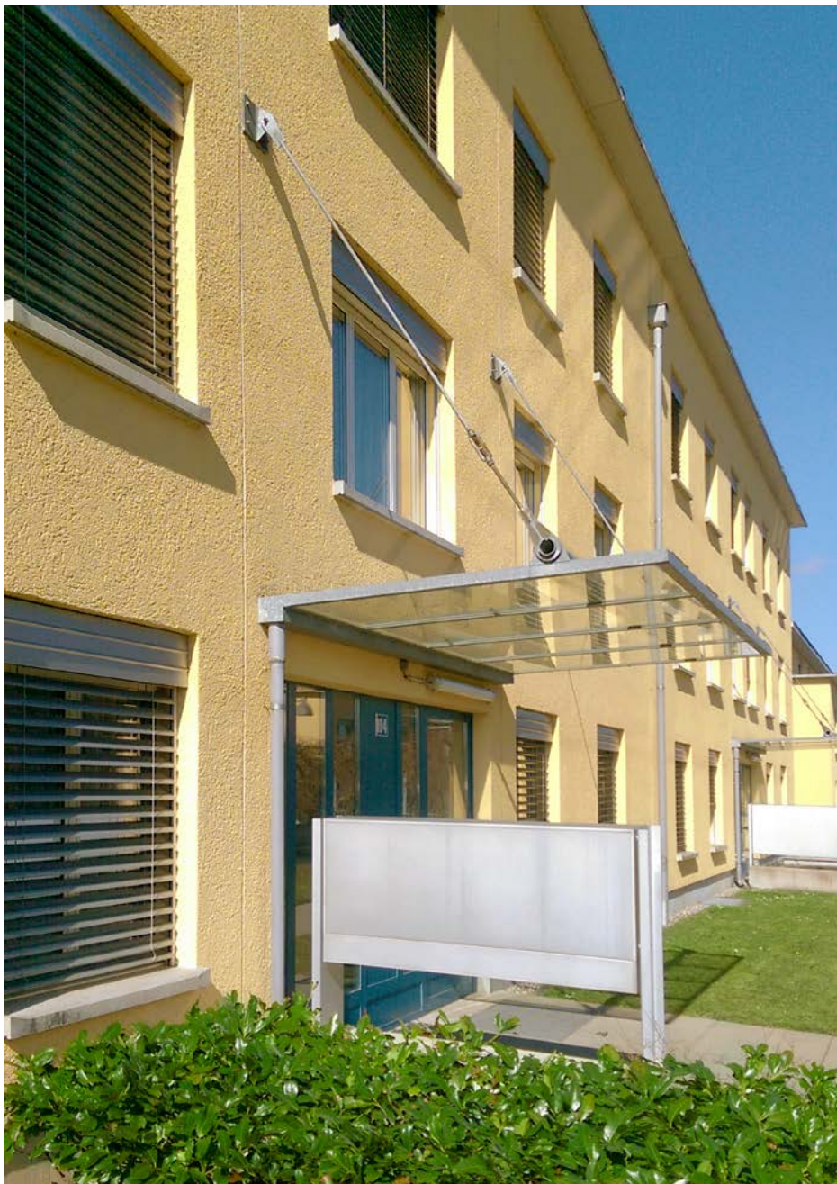
Genossenschaftsüberbauung, Affoltern ZH, Doppelschalen-Mauerwerk, reinmineralischer Aufbau, Keim'sche Silikattechnik, Purkristalat-Anstrich, 21-jährig
